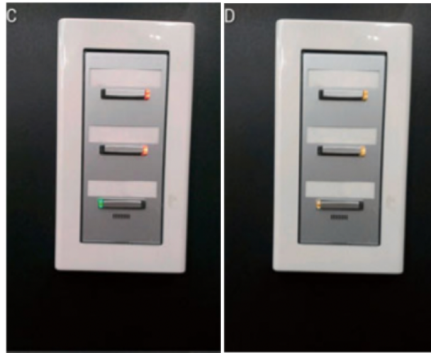
図1 一般色覚者（左）とD型色覚者（右）が見ている照明の電源例
